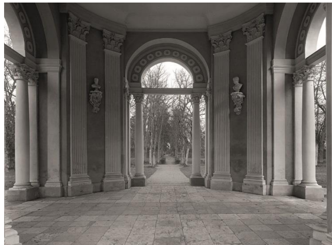
Abb. 5 Deutlich zeichnet sich in Fußbodenmitte der Reparaturstreifen mit den Betonplatten ab. - Messbildaufnahme Innenraum des Salons, um 1912, Copyright: BLDAM, Messbildarchiv Bild-Nr. 21-m-13-1616_42
