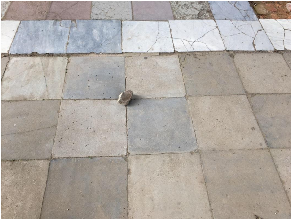
Abb. 7 Reinigungsprobe der 1897 verlegten Betonplatten, 2017, Foto: Detlef Fuchs
